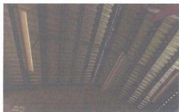
Foto 3: REPARACIÓN DEL SISTEMA ELÉCTRICO
