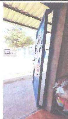
Foto 4: MANTENIMIENTO DE PUERTA
